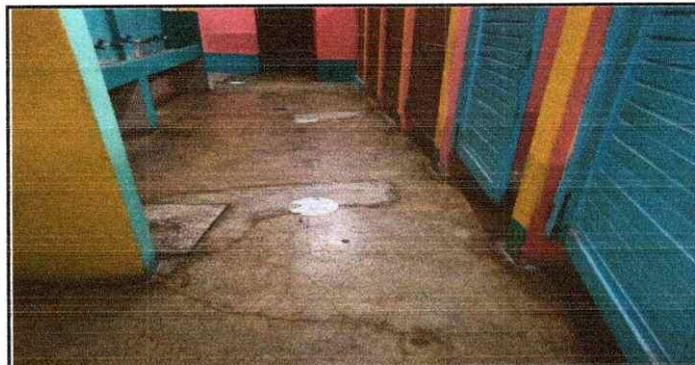
Foto 5: El piso de los sanitarios se debe de cambiar instalando piso antideslizante, para evitar accidentes con los estudiantes.
