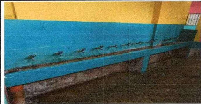
Foto 13: Se necesita instalar azulejos en lavamanos y paredes de los sanitarios, para que el agua no se filtre en la pared y provoque humedad.
