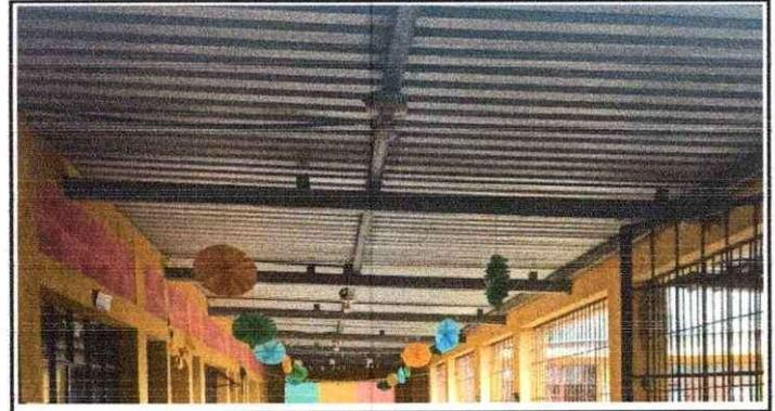
Foto 4: Instalación de cielo falso en el corredor del segundo nivel del Centro Educativo, para disminuir el calor en esta área.
