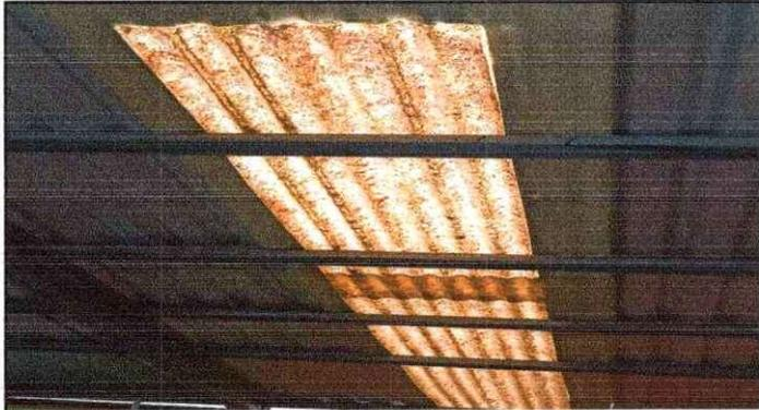
Foto1: La cubierta de lámina del segundo nivel se encuentra en mal estado, en épocas de lluvia, el agua se filtra.
