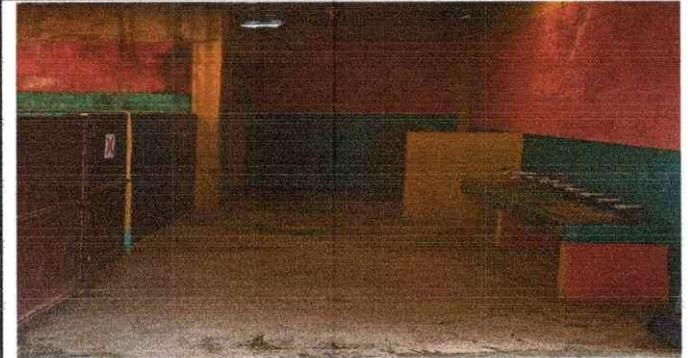
Foto 14: El piso de los sanitarios se debe de cambiar e instalar azulejo antideslizante, para evitar accidentes con los estudiantes.
