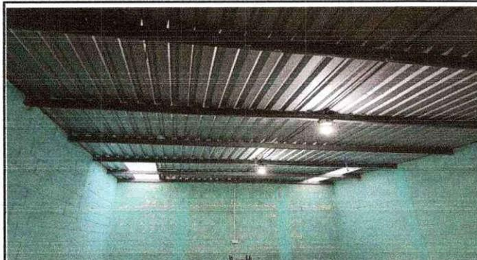
Foto 3: Es necesario la instalación de cielo falso de las aulas del segundo nivel, para poder disminuir el calor en verano, y el frío en época de invierno.
