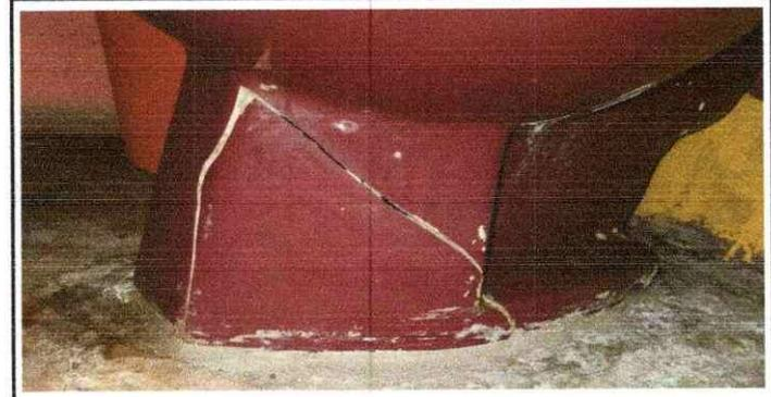
Foto 12: 4 tazas de inodoros se encuentra en mal estado, y se necesitan cambiarlos para prevenir algún accidente o enfermedad por el agua que se filtra en ellos.
